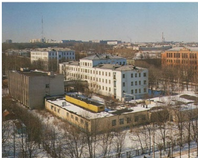
Рис. 1. Здание ГБУЗ ВО ОКОД до капитального ремонта. 1. Радиологический корпус. 2. Поликлиника. 3. Стационар. 4. Деревья на месте будущего нового хирургического корпуса.
