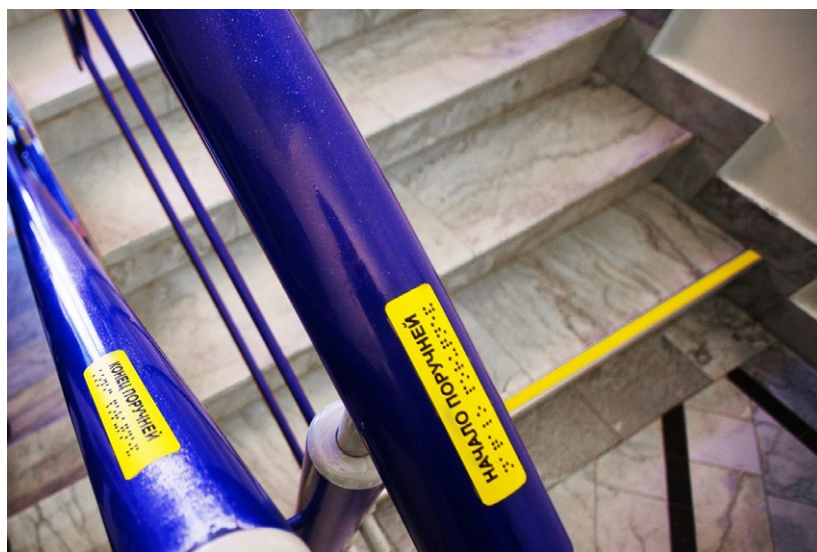
Рис. 3. Тактильные наклейки на поручнях и направляющие на первой ступеньке лестницы (Удмуртская Республика).
